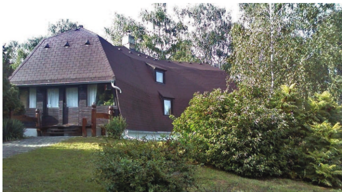
A zalaegerszegi Gébbárti Kézművesek Háza régi épületszárnya
