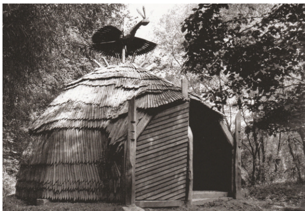
Az első, a volt Tokaji Alkotóház
